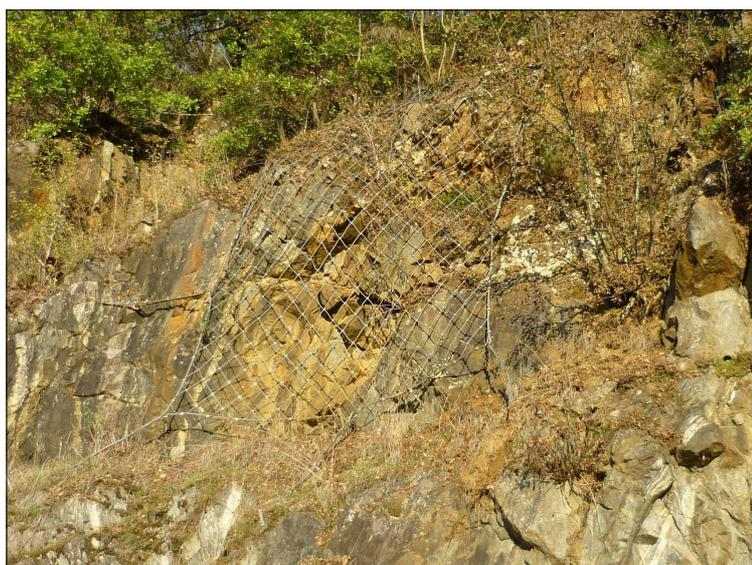
**Figure 34** : Confinement par emmaillotage derrière la caserne des pompiers [Source : IMS<sup>RN</sup>]
