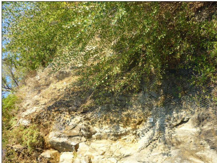
**Figure 35** : Confinement par emmaillotage derrière la caserne des pompiers [Source : IMS<sub>RN</sub>]
