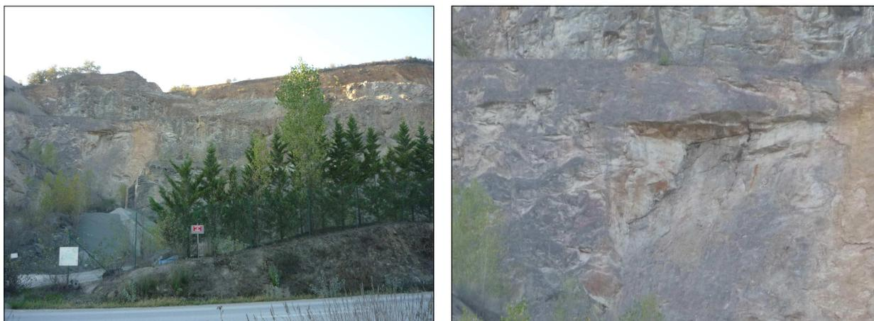
**Figure 24 :** Escarpements dans la carrière de Ginestous (à gauche) et rupture d'un dièdre (à droite)
