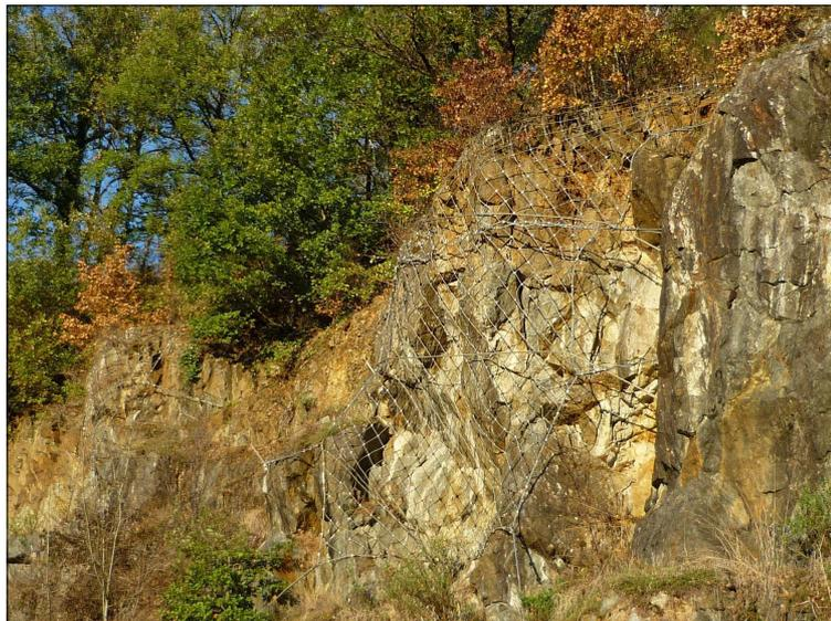
**Figure 33** : Confinement par emmaillotage derrière la caserne des pompiers [Source : IMS<sup>RN</sup>]
